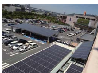
屋上や駐車場の屋根に設置された太陽光発電 Solar panels on rooftops and parking lots
