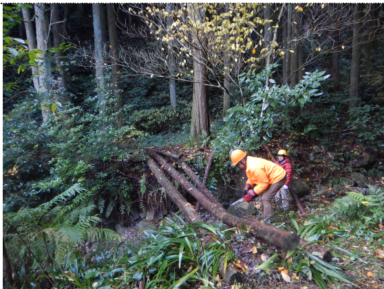
腐食した橋の撤去
