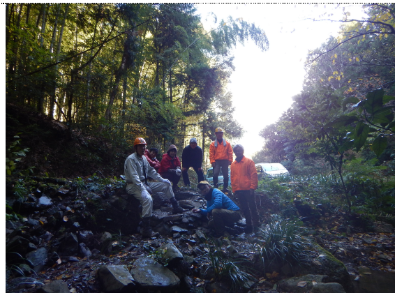
橋の撤去・石段完成！
